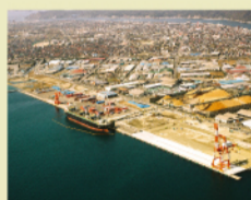
Причал класса 50000 т., оборудованный эстакадным краном Гантрикраном с 5-тонными тросами. MAP A-1
